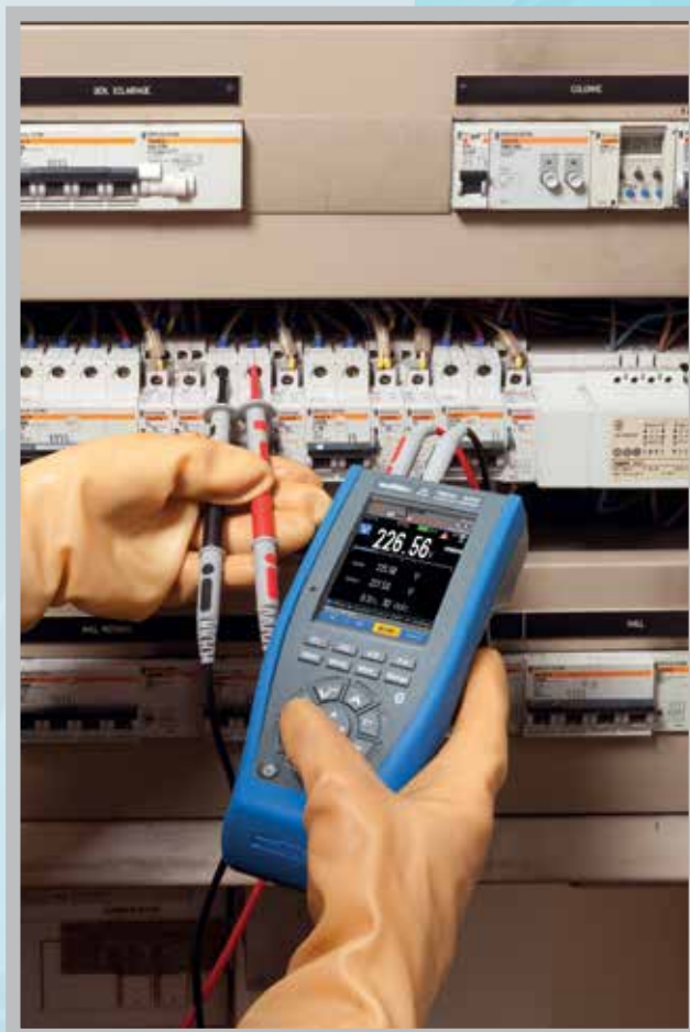
Sähkökaapeissa suoritettavat mittaukset
